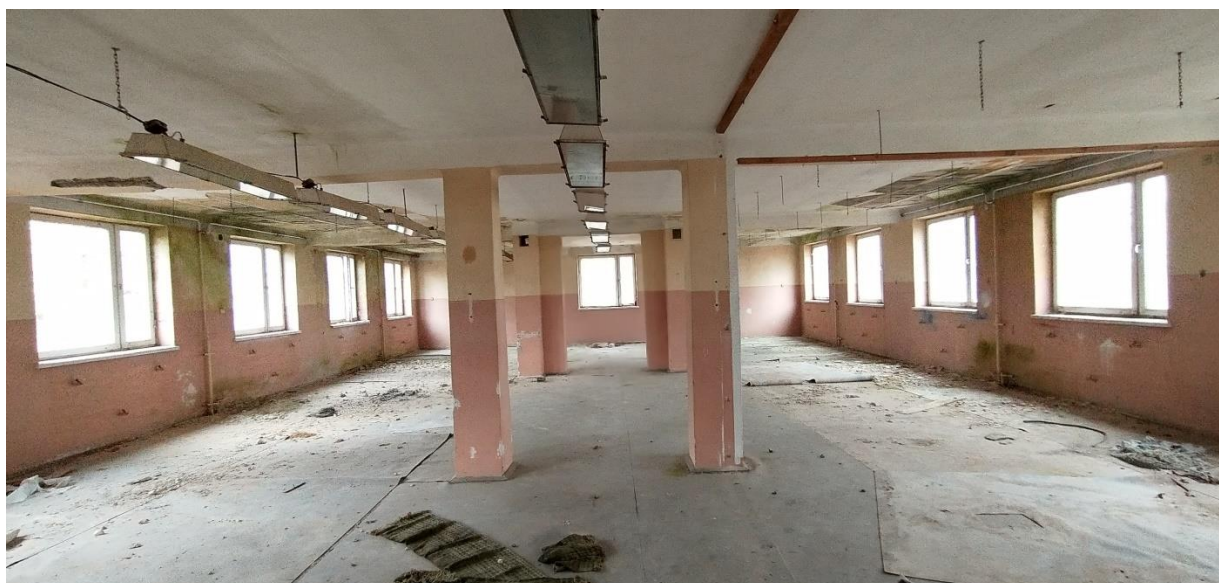
zdj. 19 Główna konstrukcja nośna piętra
