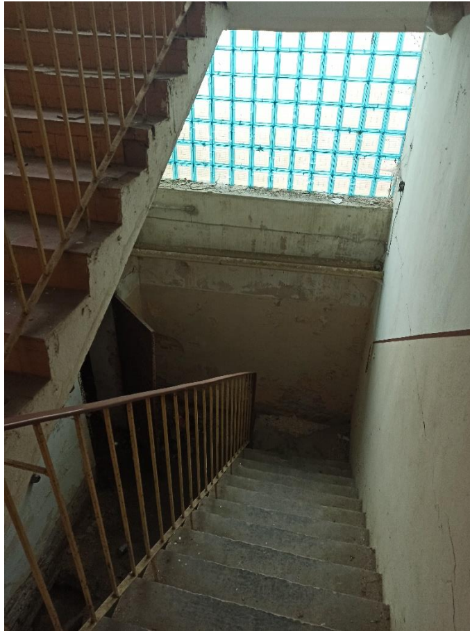
zdj. 6 Widok klatki schodowej.
