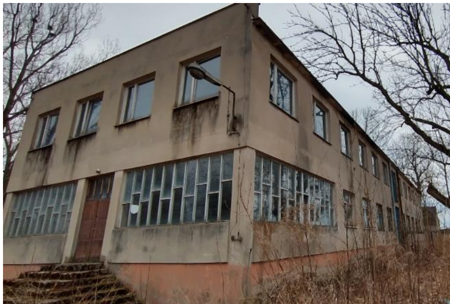
zdj. 4 Widok na elewację budynku.
