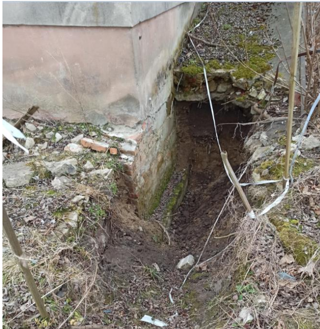
zdj.1 Odkrywka fundamentu
