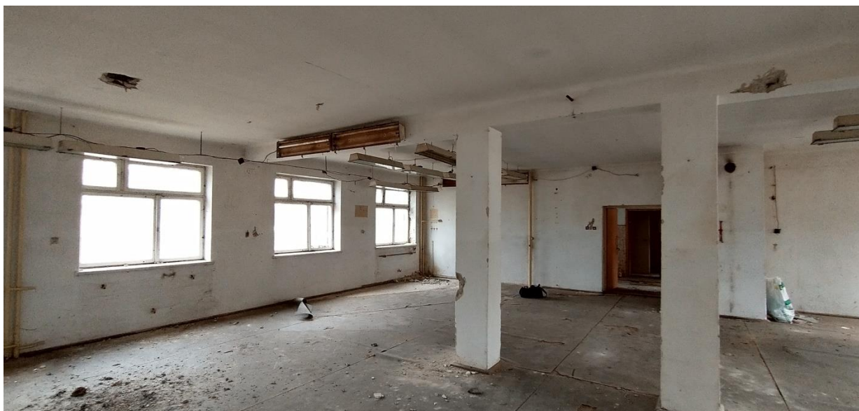
zdj. 18 Główna konstrukcja nośna parteru
