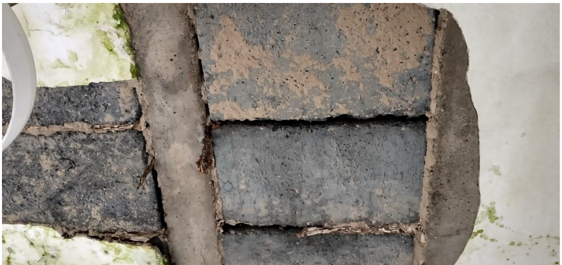
zdj. 2 Strop prefabrykowany DZ-3.
