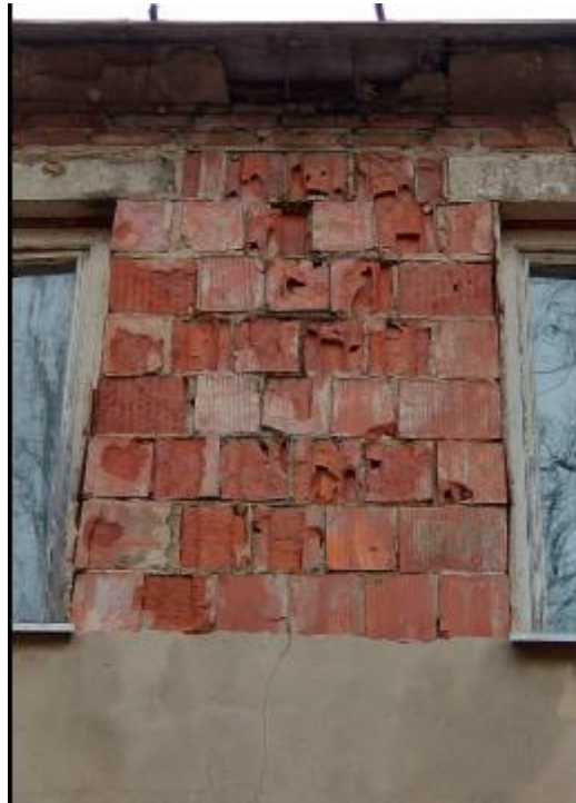
zdj. 3 Ściana zewnętrzna.
