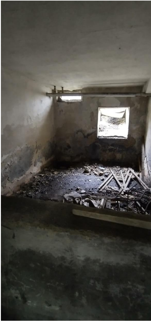
zdj. 8 Zawilgocony tynk ścian piwnic
