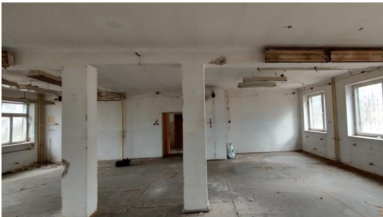
zdj. 5 Słupy i podciągi żelbetowe.
